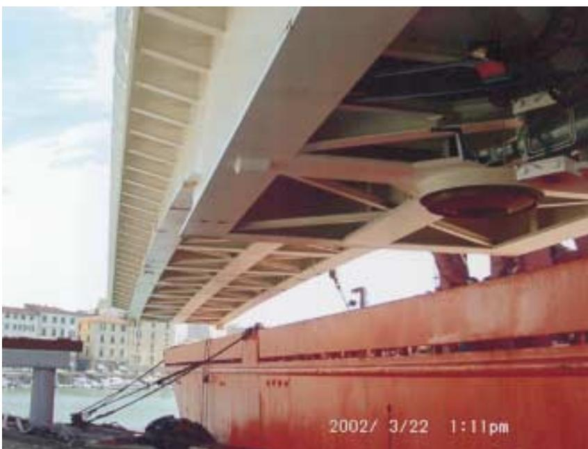
Fig. 10 - Visti inferiore della carpenteria metallica in fase di varo
