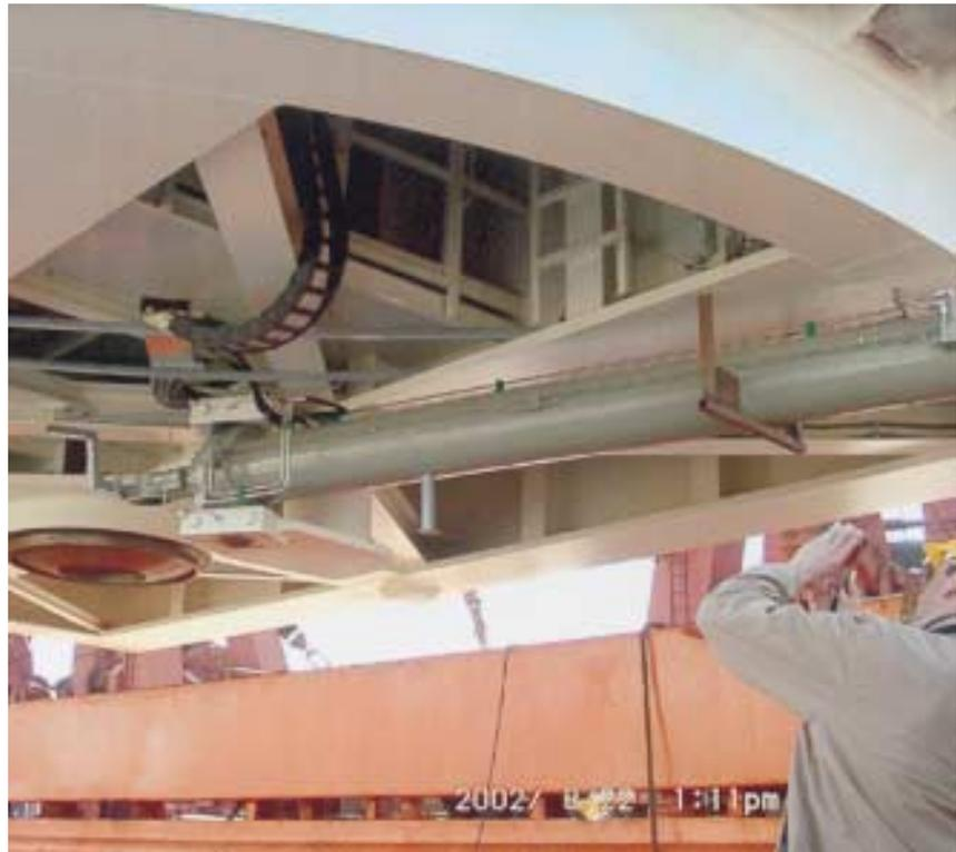
Fig. 11 - Dettaglio del sistema di movimentazione, pistone e cerniera sferica
